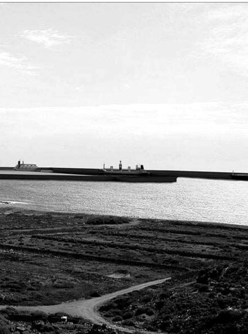
“Mínimo impacto visual”. Los responsables de Gascan, empresa que supervisará la construcción de las plantas de regasificación, insisten en que la instalación de Granadilla no tendría una presencia abrumadora en el futuro puerto industrial del Sur de Tenerife. / INFOGRAFÍA CEDIDA
